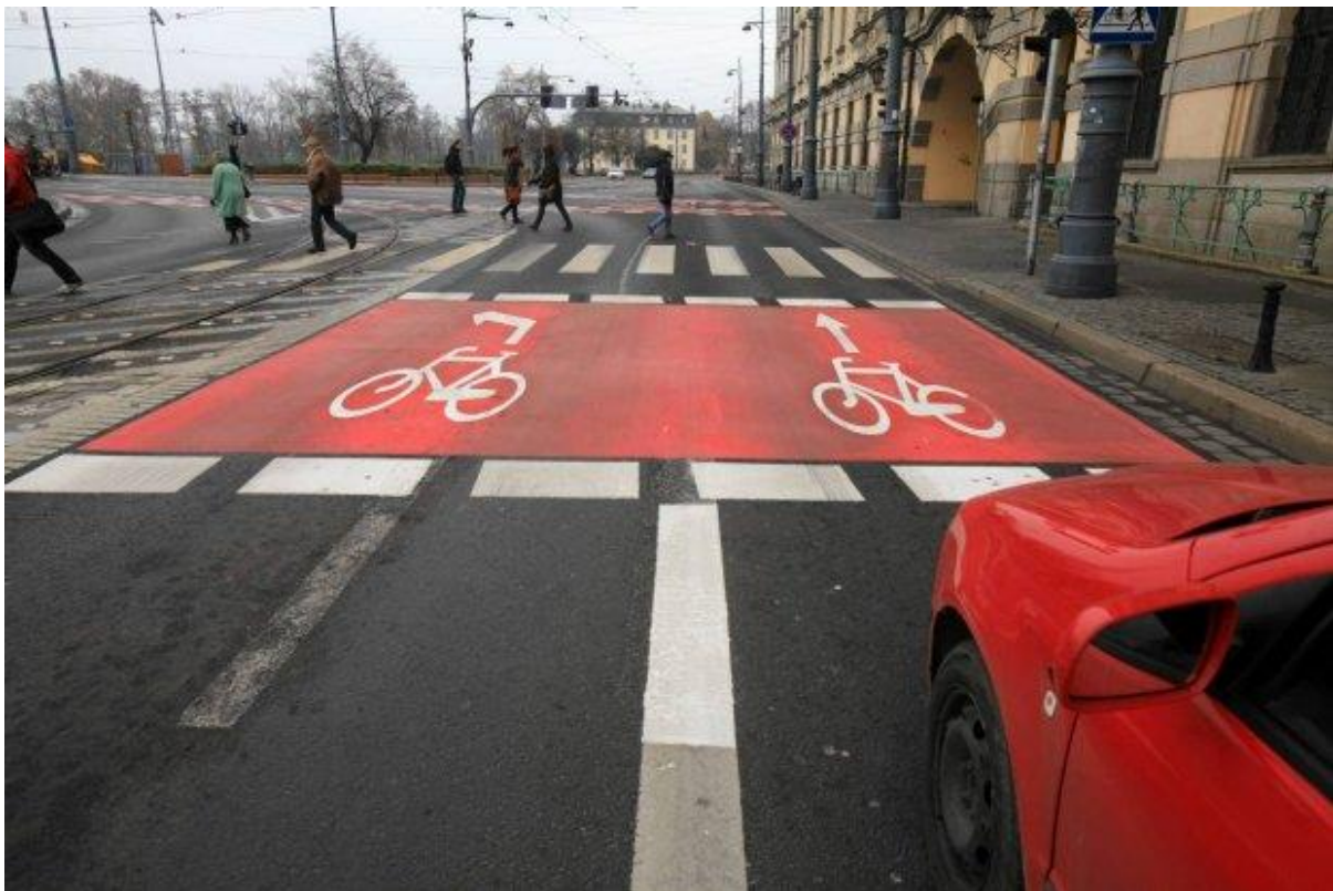
Rys 5.4 Śluza rowerowa na skrzyżowaniu we Wrocławiu.
